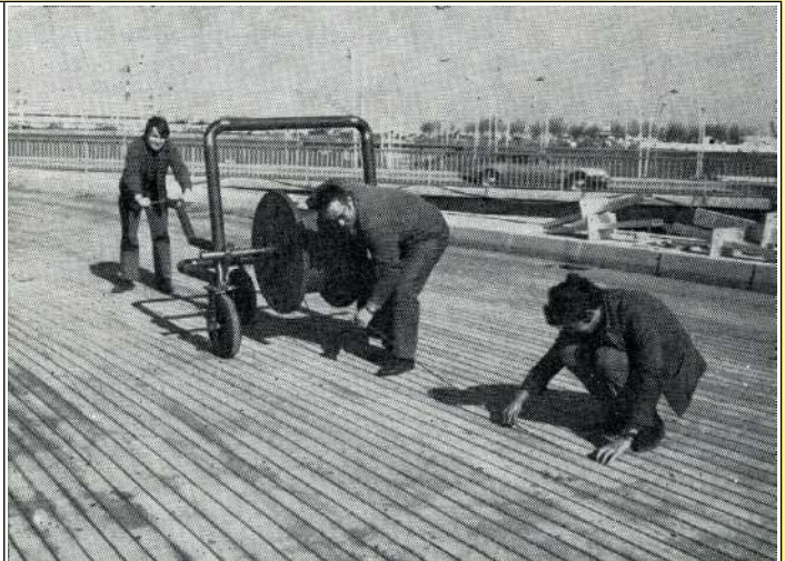
1968 Pose de la nappe chauffante sur une rampe d'accès à une plateforme de stationnement des autobus, aéroport d'Orly près de Paris (Chauffage électrique des chaussées, par Robert Félix, 1971, Musée Ultimheat*)
