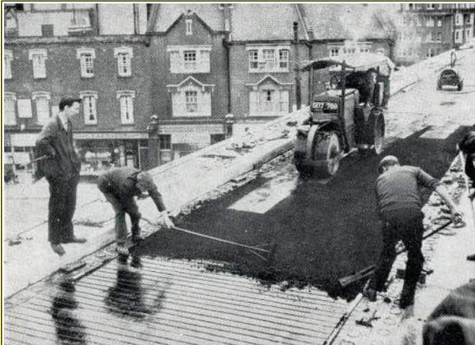
1969 Pose du revêtement sur la chaussée supérieure d'un carrefour de Hammerschmidt à Londres (Chauffage électrique des chaussées, par Robert Félix, 1971, Musée Ultimheat*)
